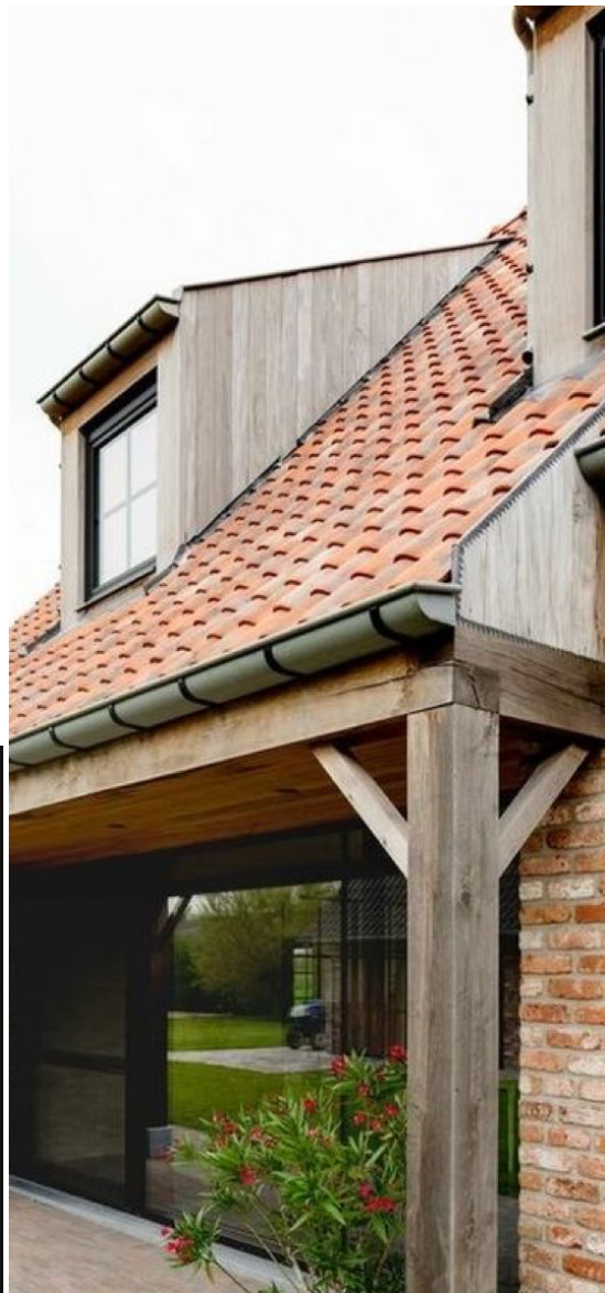
Foto: referentie uitzicht afwerking dakkapellen
