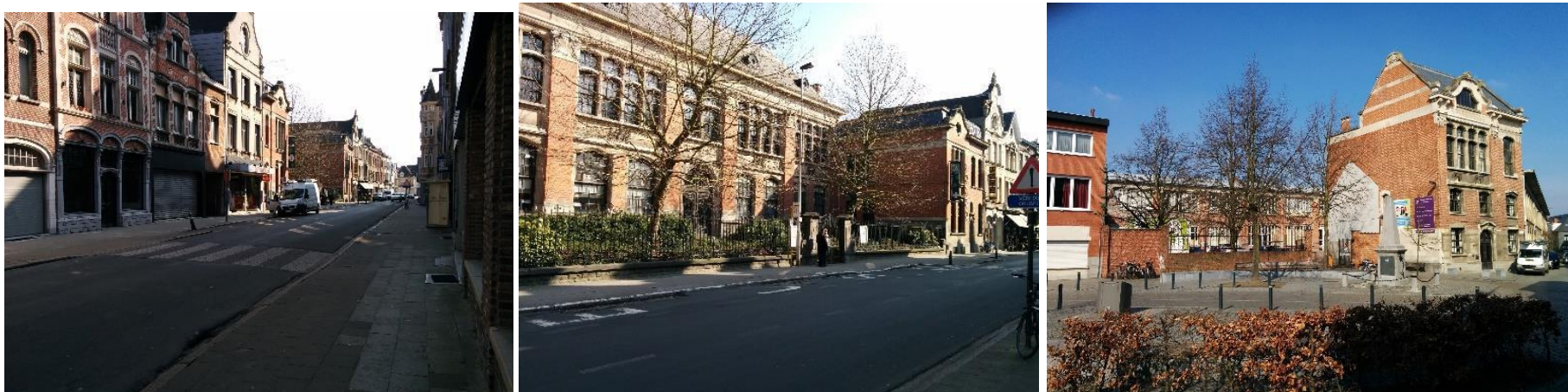
Figuur 8: Infrastructuur Berlaarsestraat (2) en Kluizeplein
